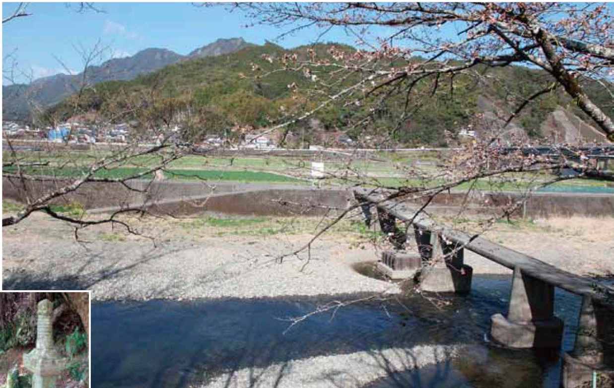
坂折川右岸から横倉山方面を仰いだ沈下橋
